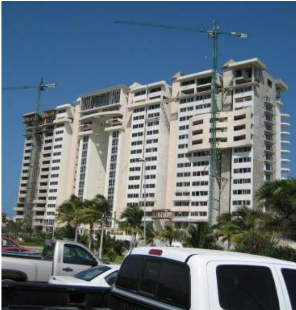
Figura 4. Edificio de 20 niveles Isola, Cancún, Q.Roo.
